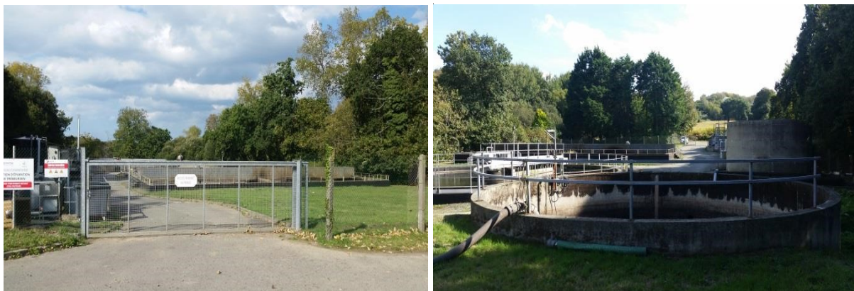
Entrée de la station d'épuration et vue globale sur la filière de traitement
